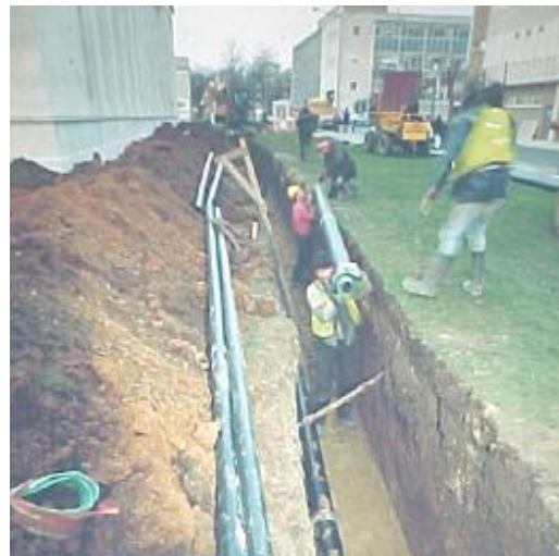
Ryc. 1. Układanie rurociągu sieci wzdłuż Civic Centre
