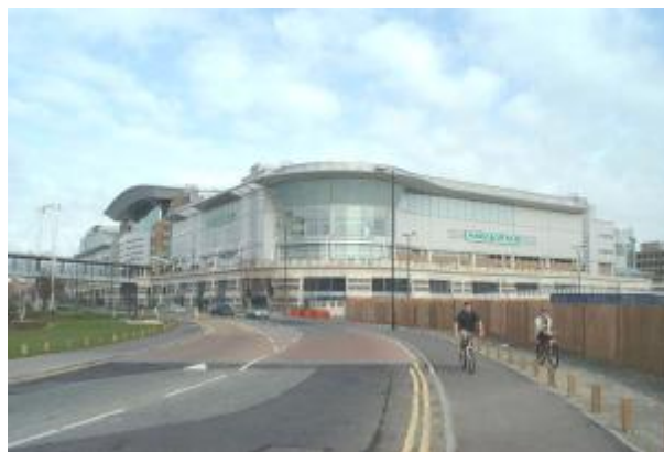
Ryc. 3. Centrum handlowe West Quay w budowie
