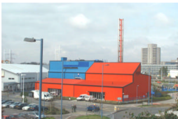
Photo 2. La station thermique
