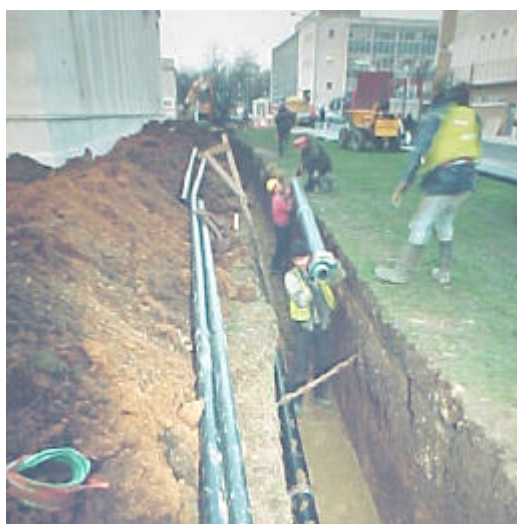
Photo 1. Pose du réseau de l'arrière du Civic Centre
