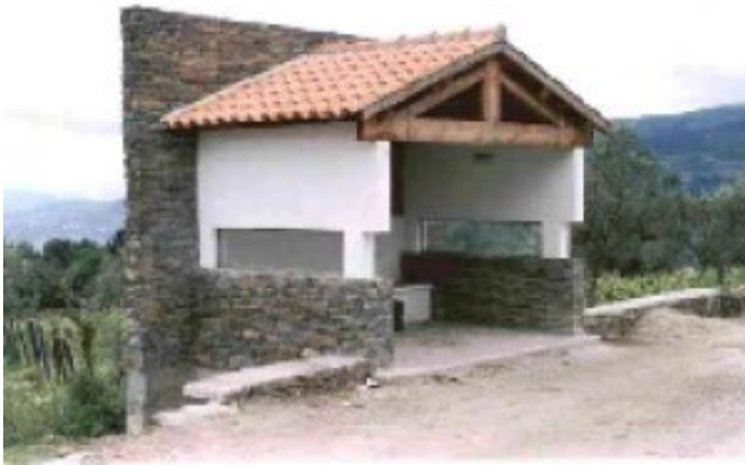
PARAGEM DE AUTOCARRO COM SISTEMA FOTOVOLTAICO
