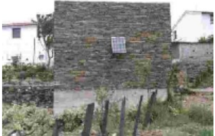
VISTA LATERAL DE PARAGEM DE AUTOCARRO COM SISTEMA FOTOVOLTAICO
