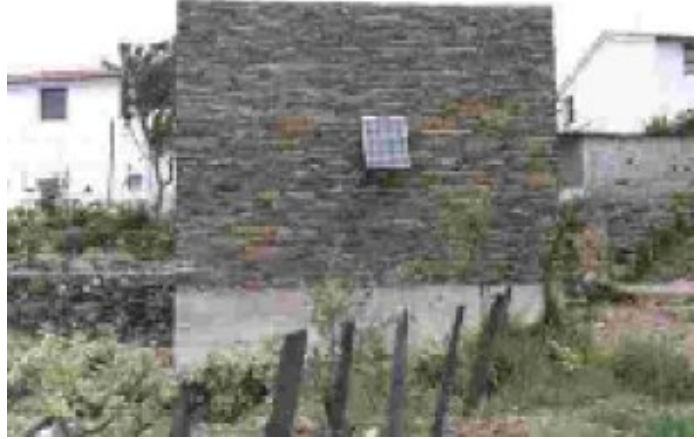
FERMATA DI AUTOBUS CON SISTEMA FOTOVOLTAICO 1
