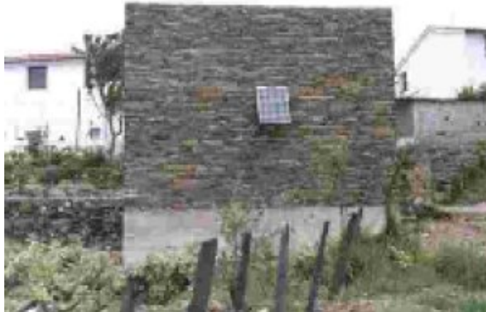
Vista lateral de una parada de autobús con sistema fotovoltaico
