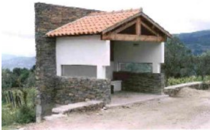
Parada de autobús con sistema fotovoltaico
