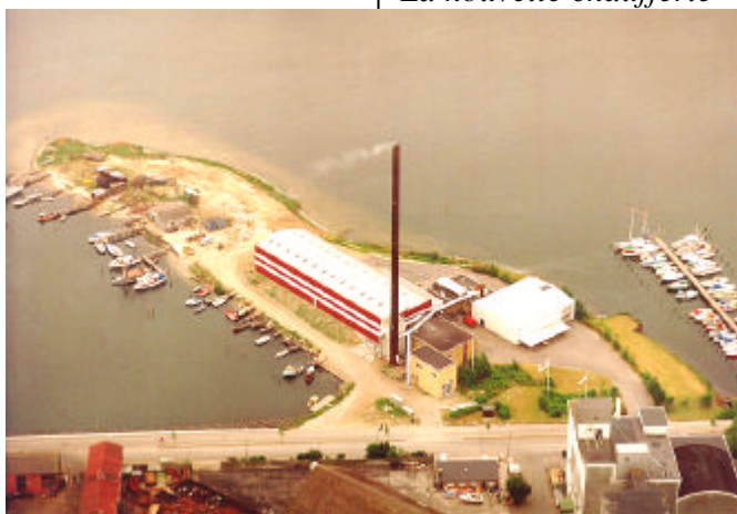
La nouvelle chaufferie
