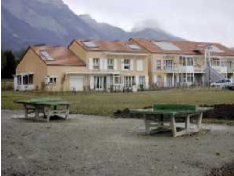
LOCUIŢELE SOCIALE OPALE: URMARIREA CONSUMURILOR ENERGETICE
