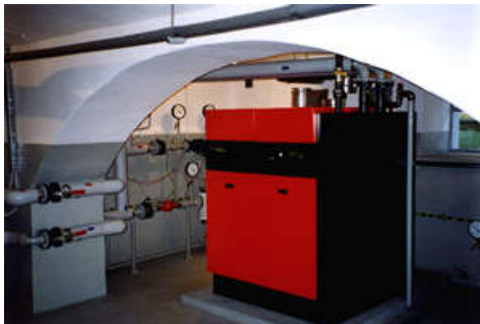
A CALDEIRA DE OKREZNA STREET DEPOIS DA MODERNIZAÇÃO
