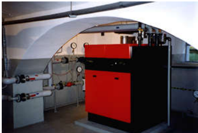
LA CALDAIA IN VIA OKREZNA DOPO IL RIMODERNAMENTO
