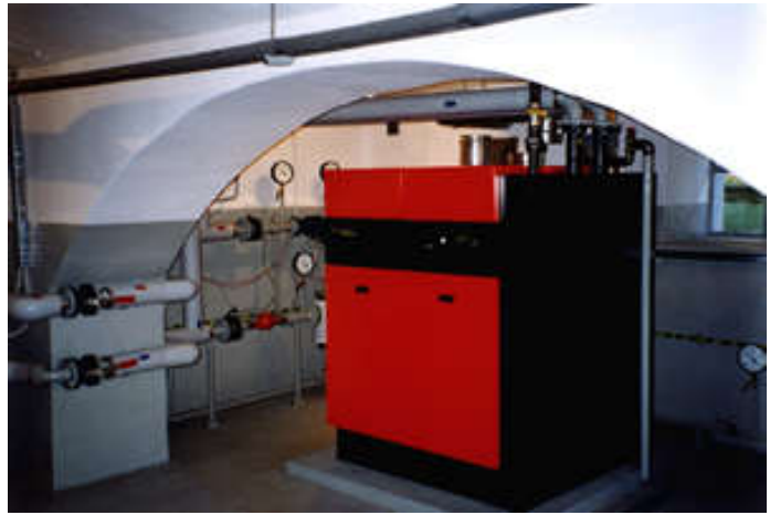
ET APRES LA MODERNISATION
