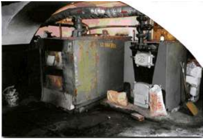
LA SALLE DE CHAUFFE DE LA RUE OKREZNA AVANT...
