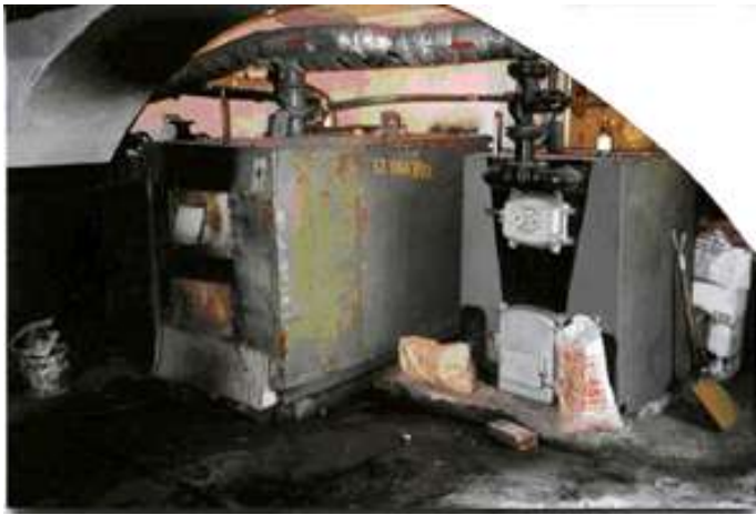
DER KESSEL IN DER OKREZNA-STRASSE VOR DER MODERNISIERUNG
