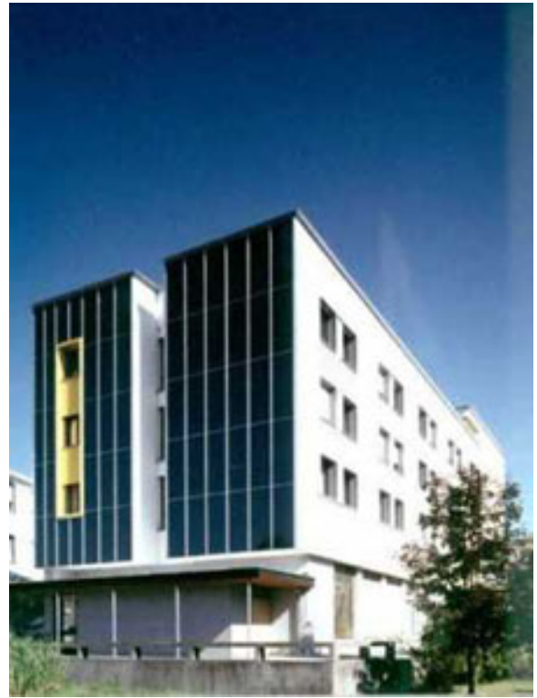
Fachada con paneles solares integrados. Kolpingheim Dornbirn
