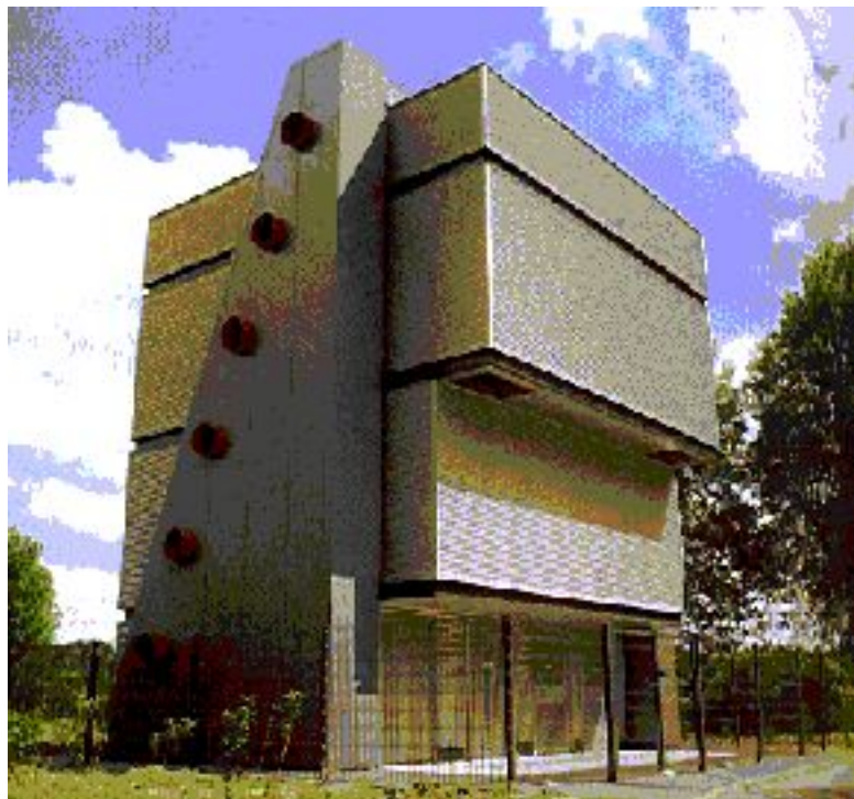
Planta de cogeneración de Arnhem
